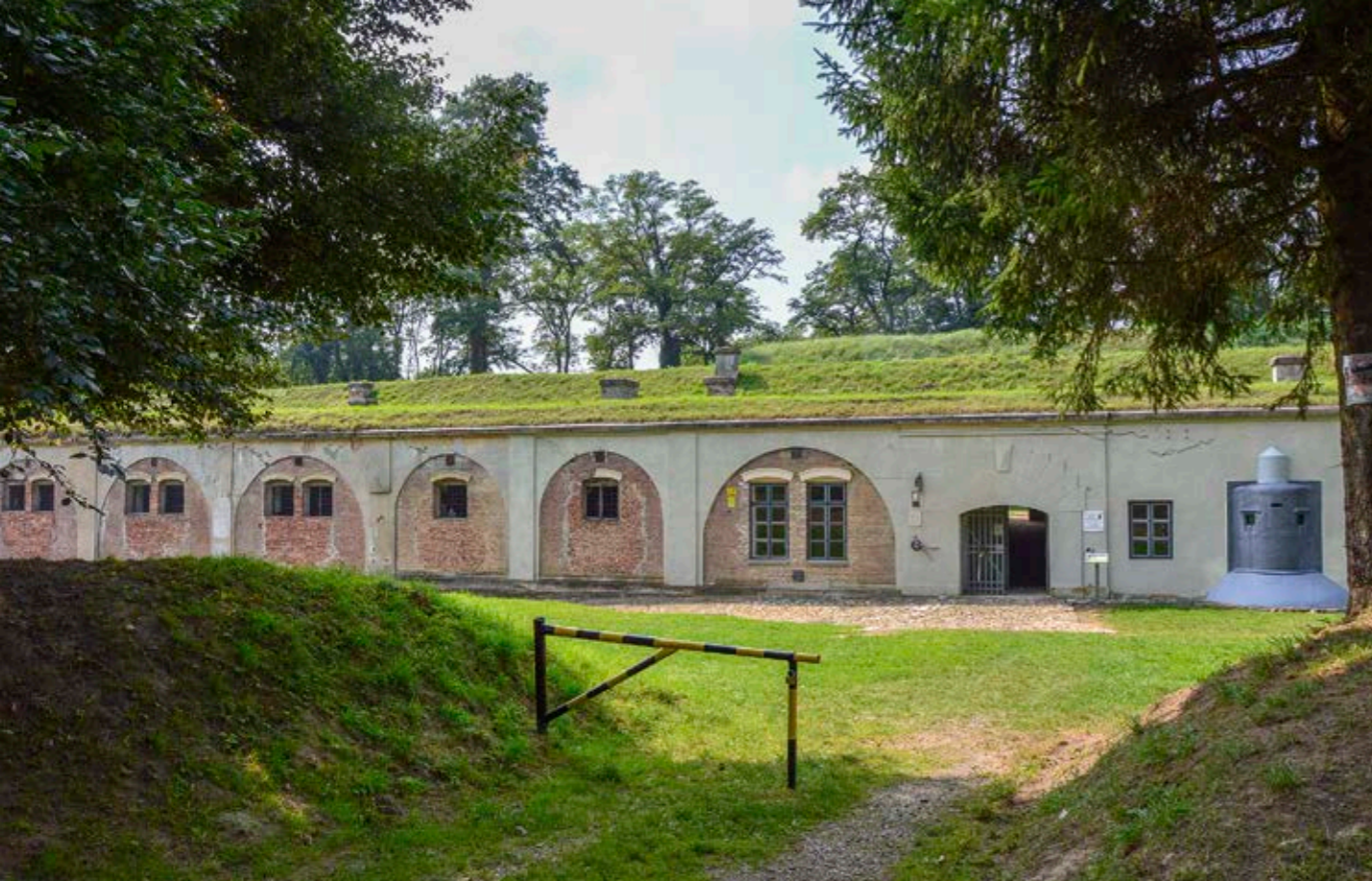
Fort W VIII „Lętownia”, centrum koszar, fot. B. Kuźniar Fort W VIII „Lętownia”, barracks center, photo by B. Kuźniar
