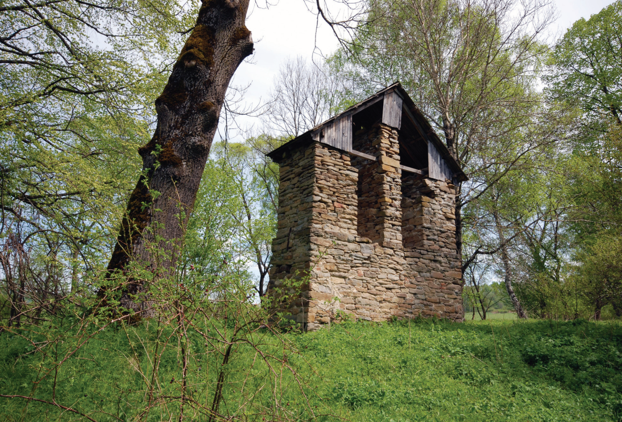
Ruina dzwonnicy cerkiewnej w Tworylnem, fot. A. Szczerbicki
